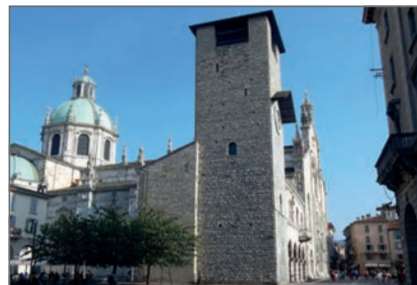
La torre civica del Boretto vista da Via Caio Plinio Secondo; sullo sfondo la grande cupola del Duomo. The Boretto civic tower seen from Via Caio Plinio Secondo; in the background the great dome of the Cathedral.
