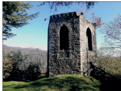
Torretta esagonale, costruita nella prima metà dell'800 dalla famiglia Venini, allora proprietaria dell'area Baradello. Hexagonal building built in the first half of the 1800's by the Venini family, then landlords of the Baradello area.
